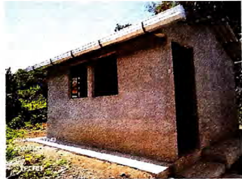
Foto 2: Finalización del cambio de techo de la cocina y canales y bajadas de agua pluvial
