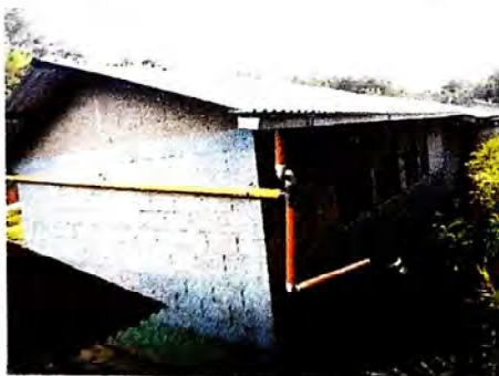
Foto 5: Colocación de accesorios para el abastecimiento de agua en la Escuela
