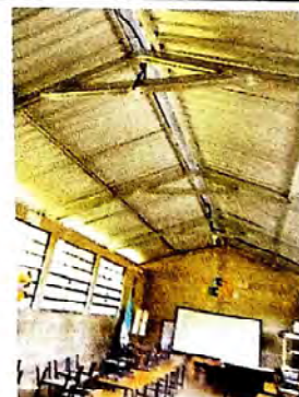
Foto 6: Colocación de costaneras, cubierta de lámina y reparación del sistema eléctrico en el aula de la Escuela Oficial Rural Mixta Chajsel
