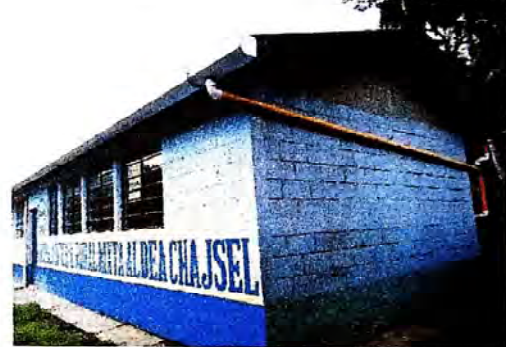
Foto 4: Colocación de canales y bajadas de agua pluvial
