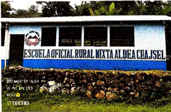
Foto 1: Módulo 1: Finalización del cambio de lámina del aula de la Escuela Oficial Rural Mixta Chajsel.
